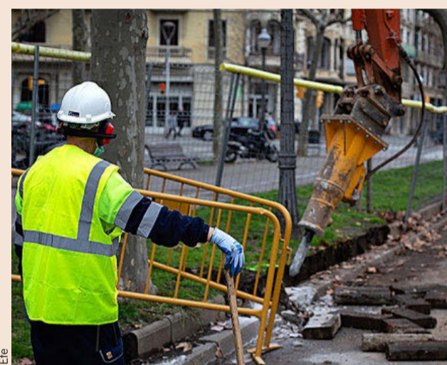
Primer día de obras en el tramo central de la Avenida Diagonal.
